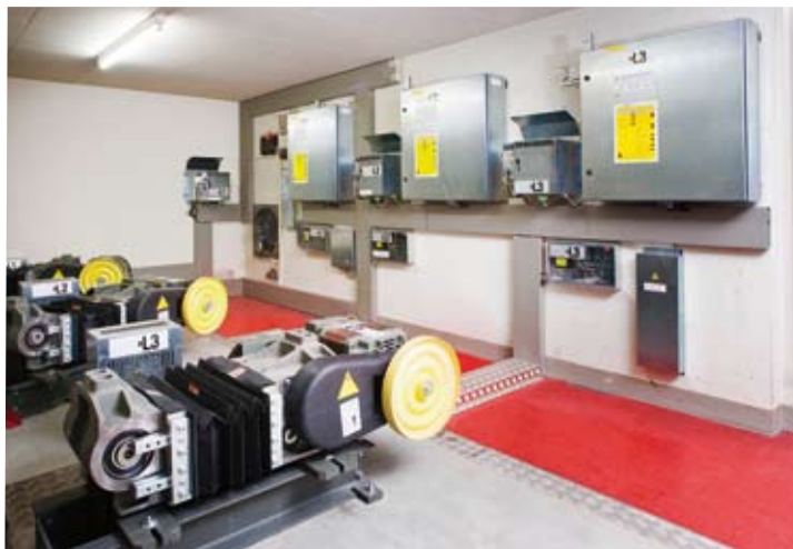
Instalación comercial Triplex operada por el grupo tractor DR SGB 142 vinculado al control de maniobra CO MX
